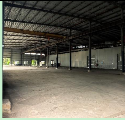
租赁厂房北侧现状
